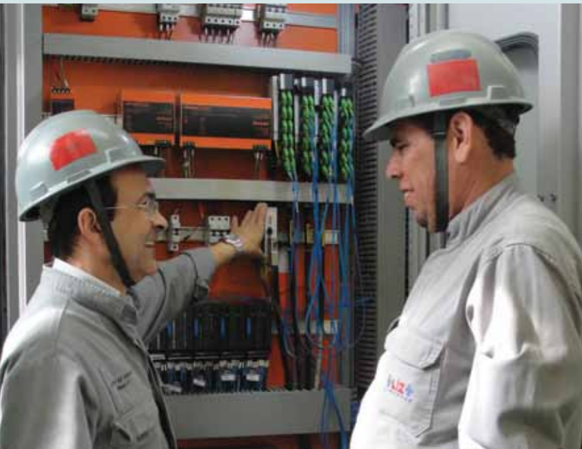
Heraldo Moreira e Ricardo Freitas ficaram encarregados de acompanhar com a equipe o desligamento e religamento de 1200 equipamentos e 19 mil pontos
